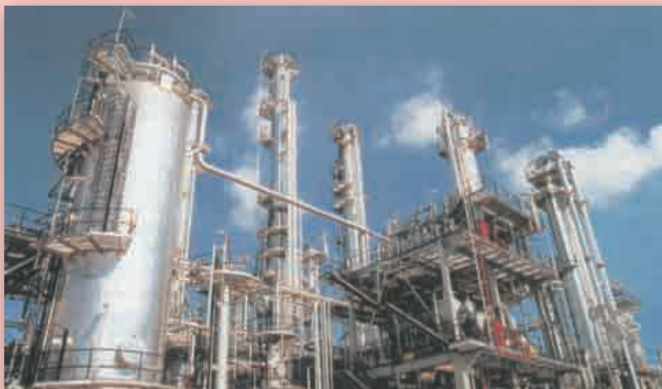
Nhà máy lọc hoá dầu
