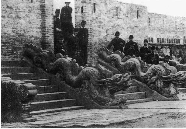
Hình 56. Quân Pháp chiếm thành Hà Nội, xây dựng lô cốt trên nền Điện Kính Thiên
