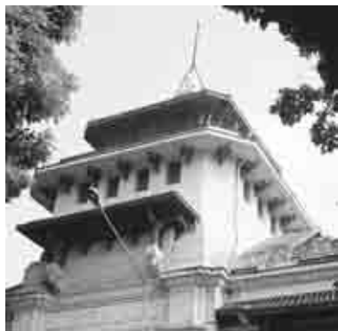
Hình 22.6 Cột chống sét.
