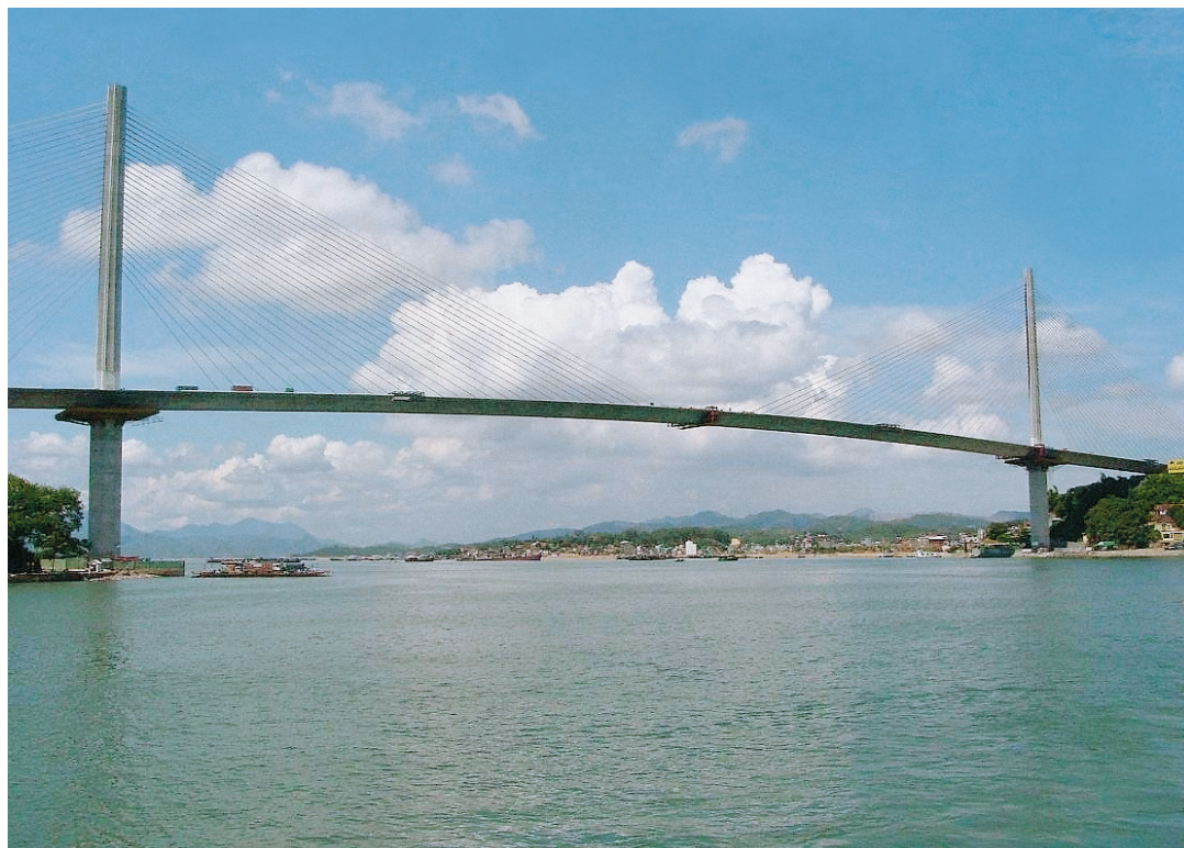
Cầu Bãi Cháy (Quảng Ninh)
